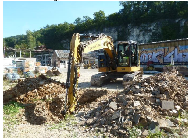
BS4 – Auffüllung mit Gehängeschutt und Gesteinsplatten
